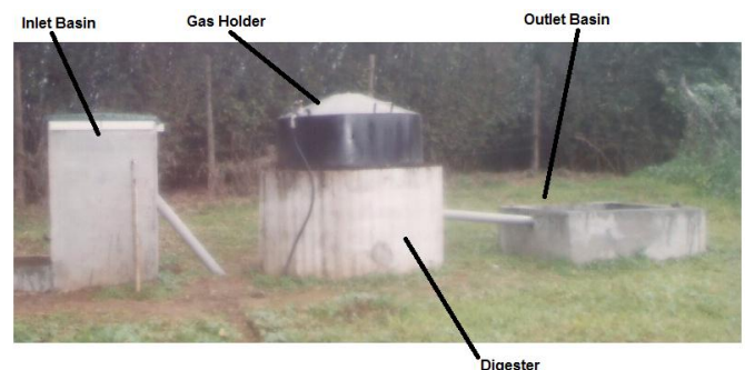
Fig. 1 A KVIC type digester
